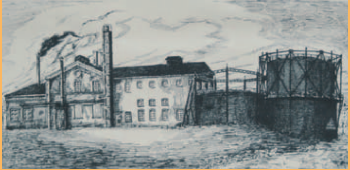
Gräfrather Gaswerk am Bergerbrühl (Repro: Bericht Betriebswerke Gräfrath 1912–1926)
