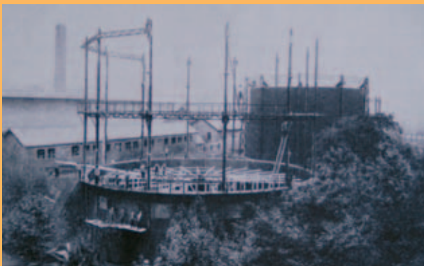
Bau eines neuen Gasbehälters, 1900 (Stadtwerke Solingen, Jahresbericht 1957)
