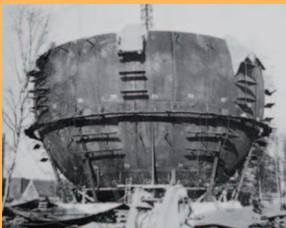
Bau des Kugelgasbehälters, 1956/57
